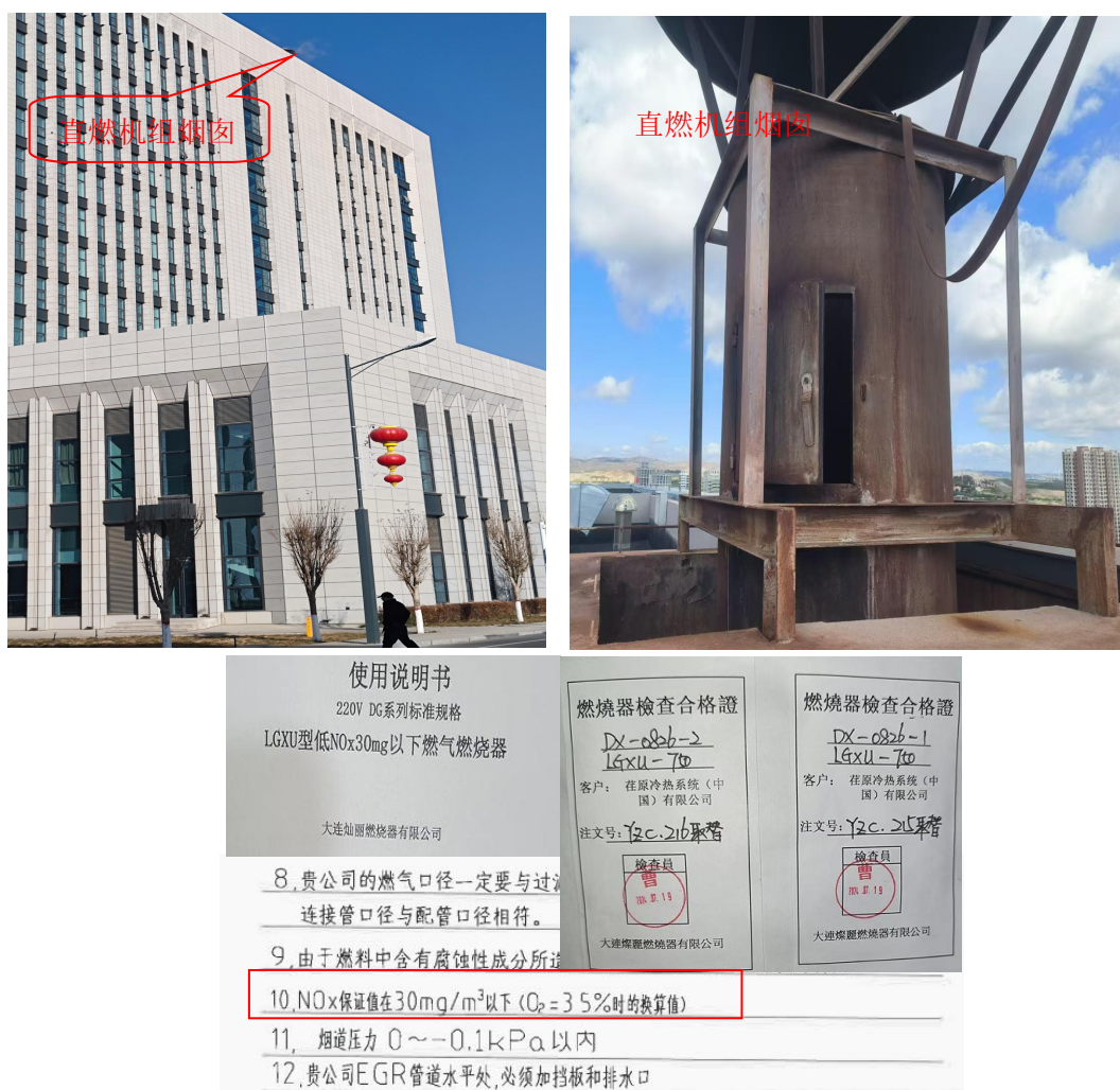
图 9 本项目烟囱现场照片
